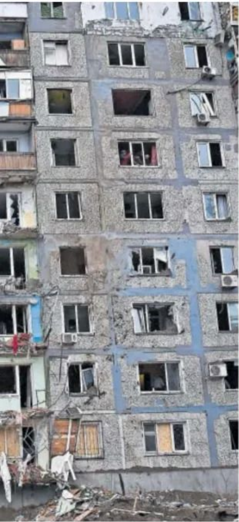
Un edificio residencial destruido tras el ataque de ayer en Zaporizhzhia (Ucrania).
